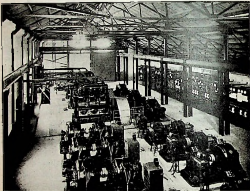
Bodmin-zendstation. Straalzender, gebouwd door de Marconi Cy. voor de Britsche rijkstelegraaf, in de heide, 5 mijlen van Bodmin op den weg naar Truro. De photo toont de machinehal met schakelborden en verlichtingsinstallatie, terwijl verder hier de energie wordt opgewekt voor toevoer aan de zendlampen.
